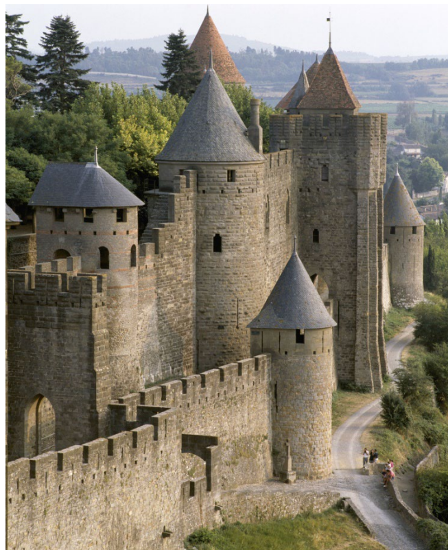
8. Vue des remparts côté ouest
