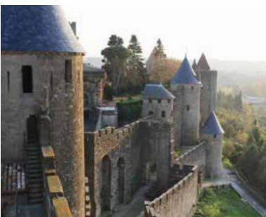
Vue sud de la Cité
